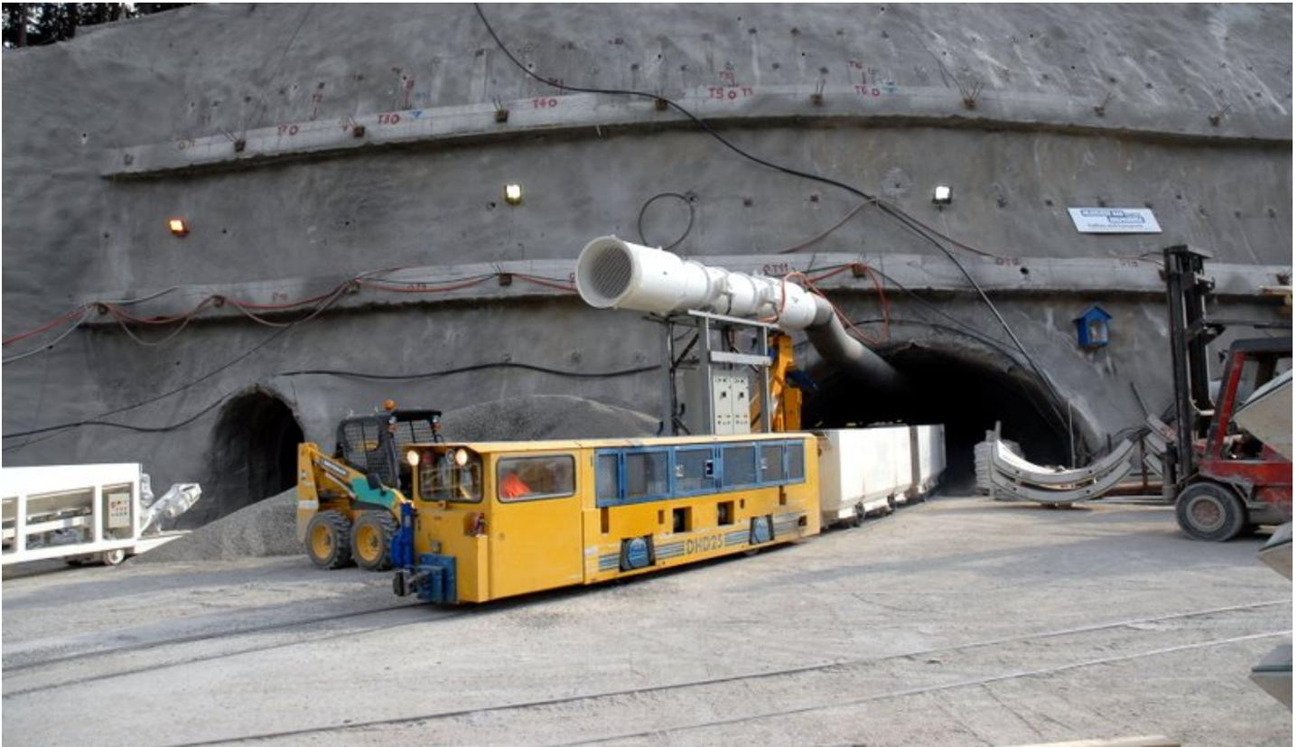
Das Aushubmaterial aus dem Zulaufstollen wird mit dem Zug zum Stollenausgang bzw. zur Laderampe der Materialseilbahn gebracht.
