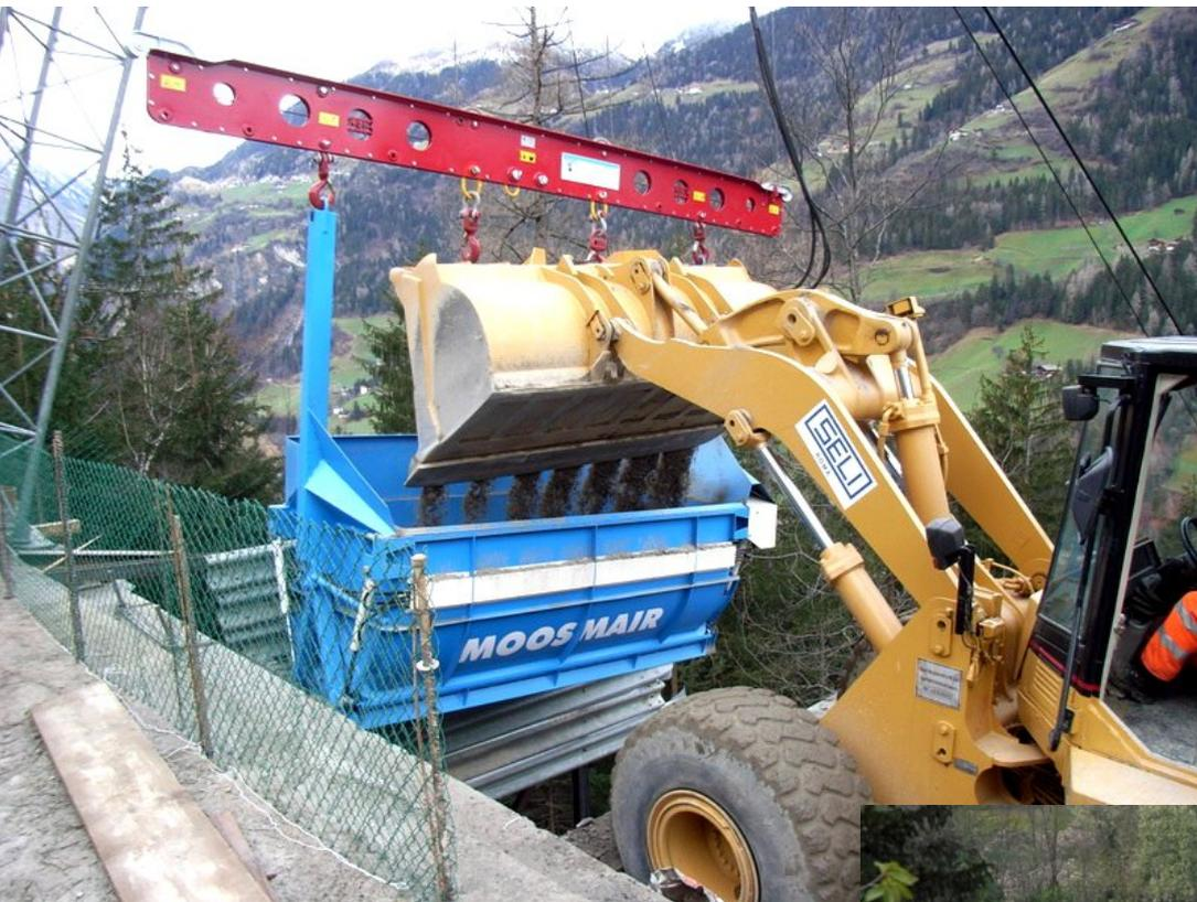
An der Laderampe wird das Aushubmaterial per Radlader in die Transportwannen der Seilbahn gefüllt und per Fernbedienung talwärts geschickt.
