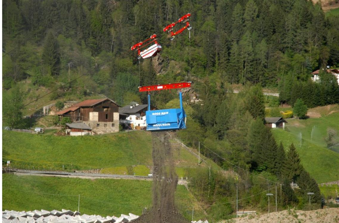
Im Tal angekommen wird automatisch die hydraulische Entladevorrichtung ausgelöst und das Aushubmaterial kann aus der Ladewanne fallen. Gleichzeitig ist die zweite Ladewanne am Berg angekommen und kann dort befüllt werden. Durch Austauschen des Transportmediums mit einer Ladegabel können auch die Betonfertigteile zum Auskleiden des Zulaufstollens befördert werden.
